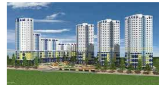
ЖК «Флагман» г. Екатеринбург, ул. Репина-Заводская-Начдива Васильева, секция Ж, Е
